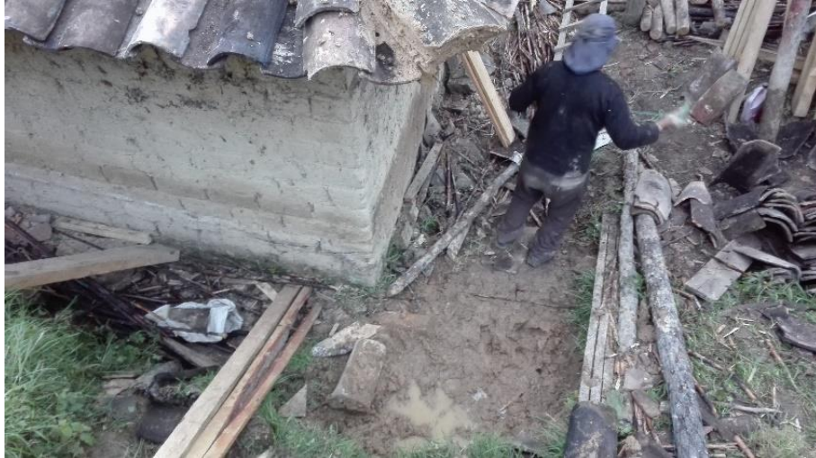
Foto 10 Construcción de tejado sobre una casa de adobe. Cevallos, L. (2019)
