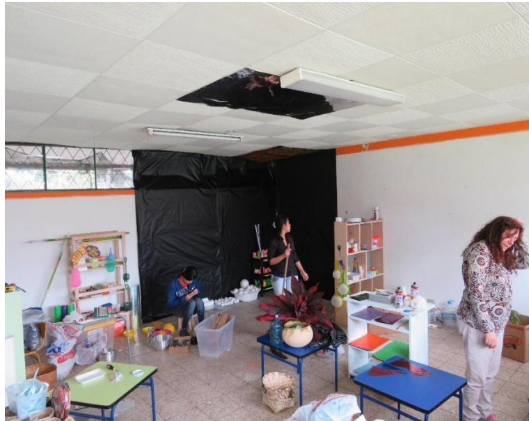
Figura 14. Construcción del atelier. Archivo del investigador. 2019
