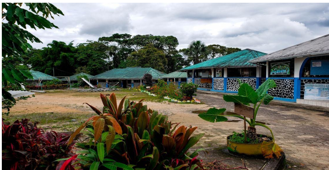
Figura 8. Área de aulas octogonales ubicadas al ingreso de la institución. (Fotografía de: Christian Morocho, 2019)
