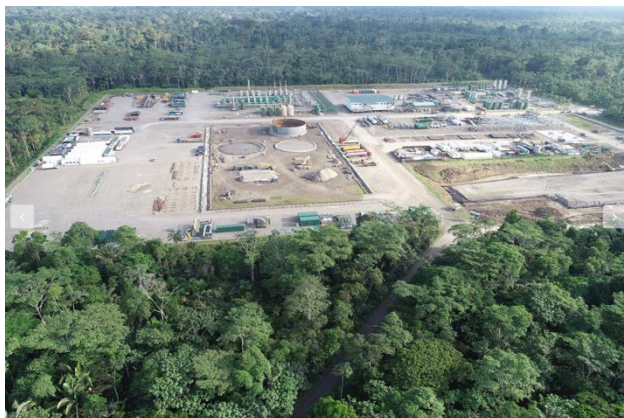
Figura 3: Tanques de almacenamiento de agua. Bloque 43. Exterior del Parque Yasuní, Ecuador.
